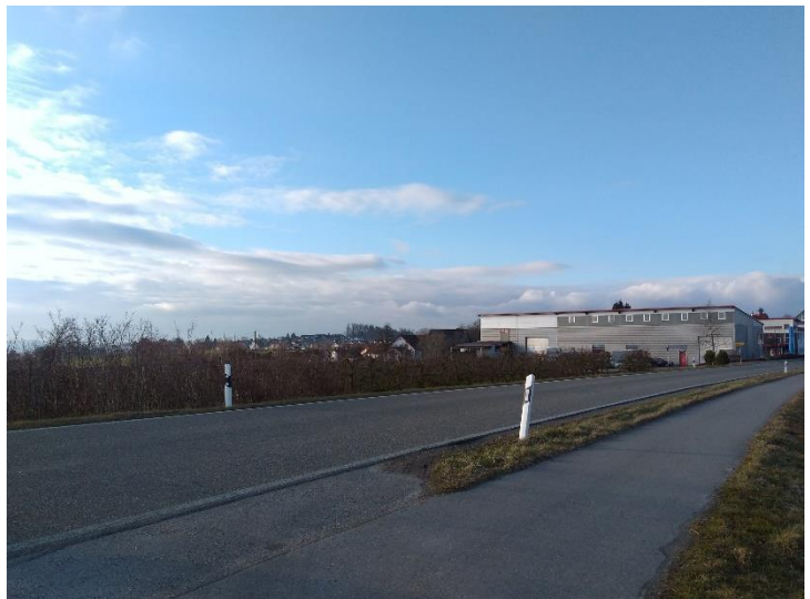
Blick von der Kreisstraße "K7955" auf süd-östlichen Teil des Plangebietes
